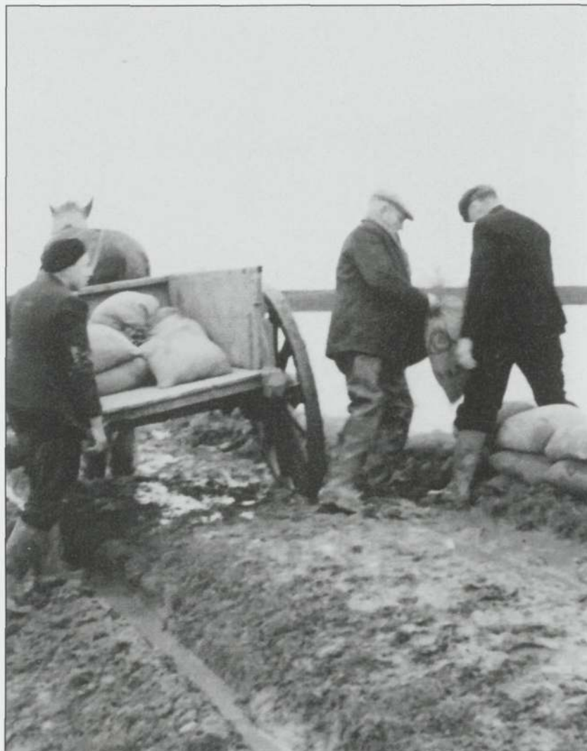
Mensen leggen zandzakken langs de IJssel in de Bakerwaard. Het paard strekt de stootkar tot vlak bij het water.
