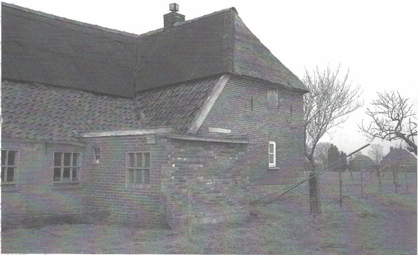
Foto is gemaakt in 2008 aan de Z.E. weg nr 14 in Toldijk. Aan de zijkant van de boerderij is de aanbouw gesitueerd met daarin het toilet.
