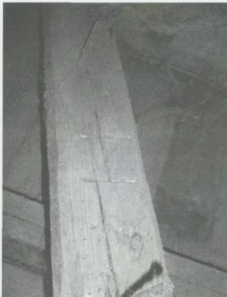
Telmerken (merktekens) om aan te geven in welke volgorde de constructie opgebouwd moest worden.
