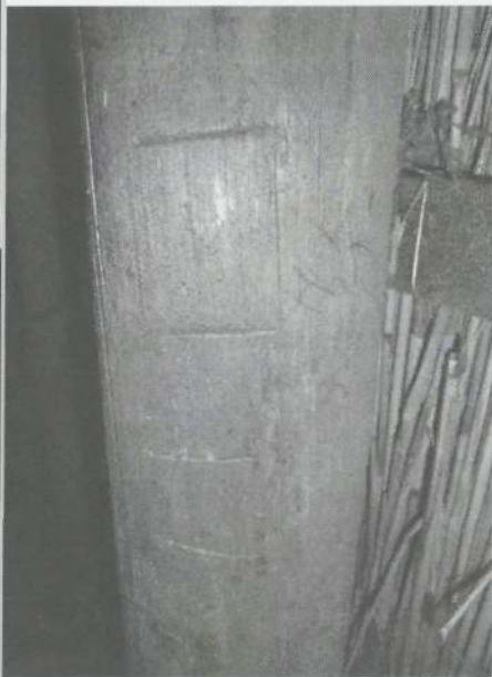
Telmerken (merktekens) om aan te geven in welke volgorde de constructie opgebouwd moest worden.
